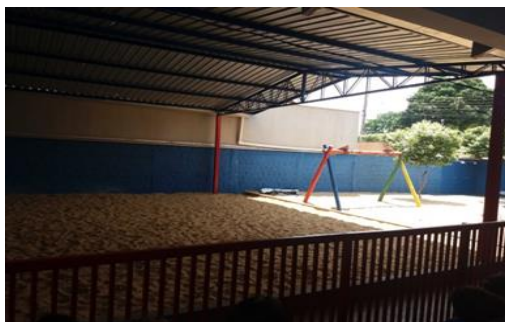
Figura 3: Caixa de areia coberta
